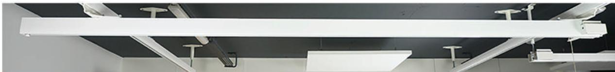
L'installation d'un rail mobile combiné à deux rails fixes permet la configuration en H du système de rails. Cette configuration est la plus flexible car elle permet les transferts sur toute la surface, quelle que soit la configuration du mobilier dans la pièce.
